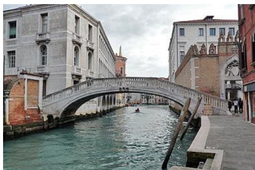
Ponte de la Ceraria sul rio Novo (arco policentrico)
