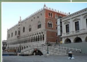
PONTE DELLA PAGLIA
