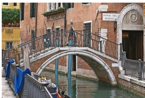
Ponte di San Provolo sul rio del Vin (arco a tutto sesto)
